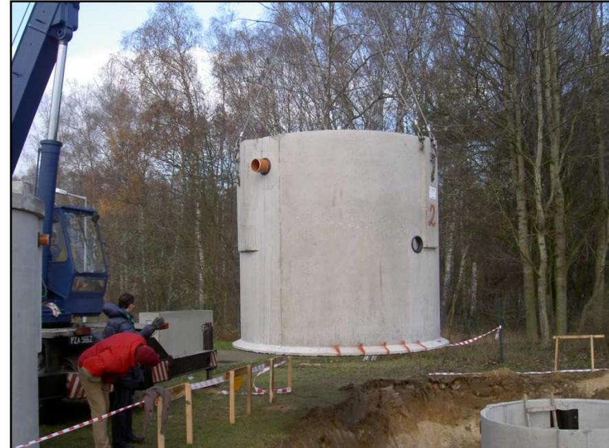
Station de traitement pour **150 habitants** . Die la forme de construction des réservoir de traitement peut avoir une forme ronde ou elle être fabrique sur place en forme rectangulaire
